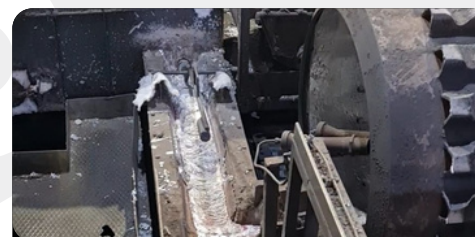
RETROFIT SU FORNI FUSORI ESISTENTI
